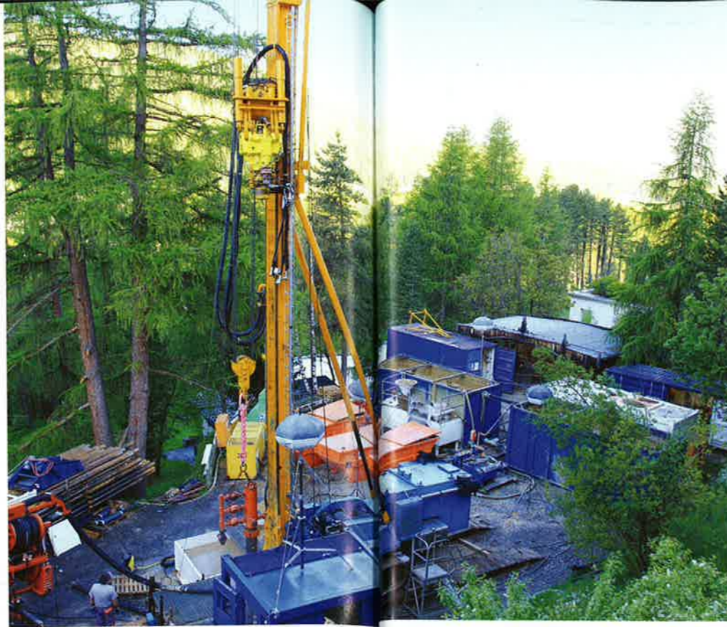
Es dauerte, bis ein Unternehmen gefunden war, das die Bohrung in Granit und die Zementierung bis auf 1.350 Meter Tiefe fachgerecht umsetzen konnte.
